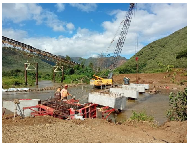
Pieux d'un ouvrage d'art
