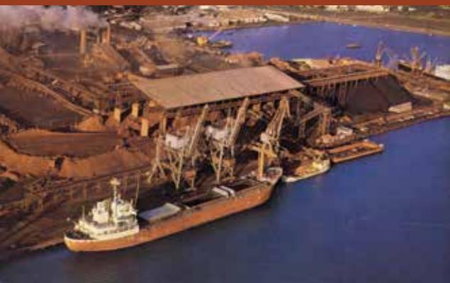
À partir de 1955, une usine B est ajoutée à l'unité de production de matre de Doniambo. Le Nickel met en œuvre un procédé de fusion électrique du minerai permettant de fabriquer du ferronickel, dont la demande par les aciéristes est plus forte que celle de la matre. Huit fours Elkem sont installés. Pour les alimenter, la société Le Nickel finance la construction du barrage de Yaté et une centrale hydroélectrique, ce qui lui garantit contractuellement 90 % de l'énergie produite.
