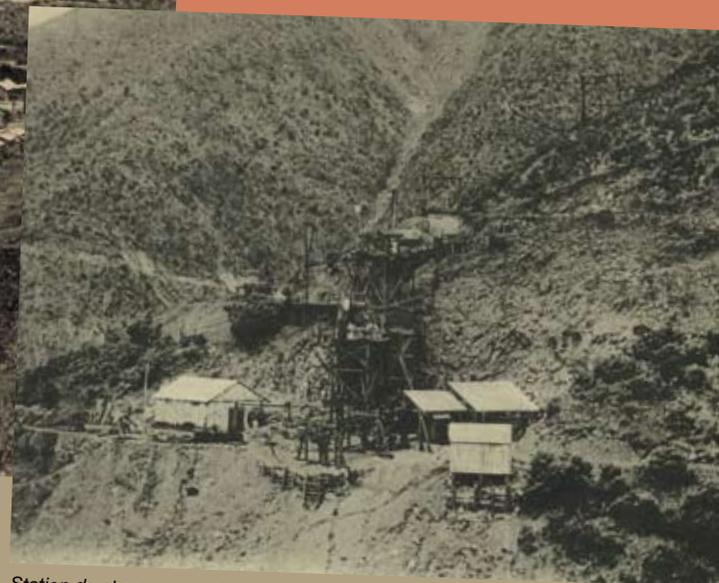
Station de chargement du transporteur des Bornet : les minerais, qui sont descendus de la mine Bornet 2 par va-et-vient, sont transbordés dans les wagonnets du transporteur qui les emporte jusque dans la vallée de la Thio.
