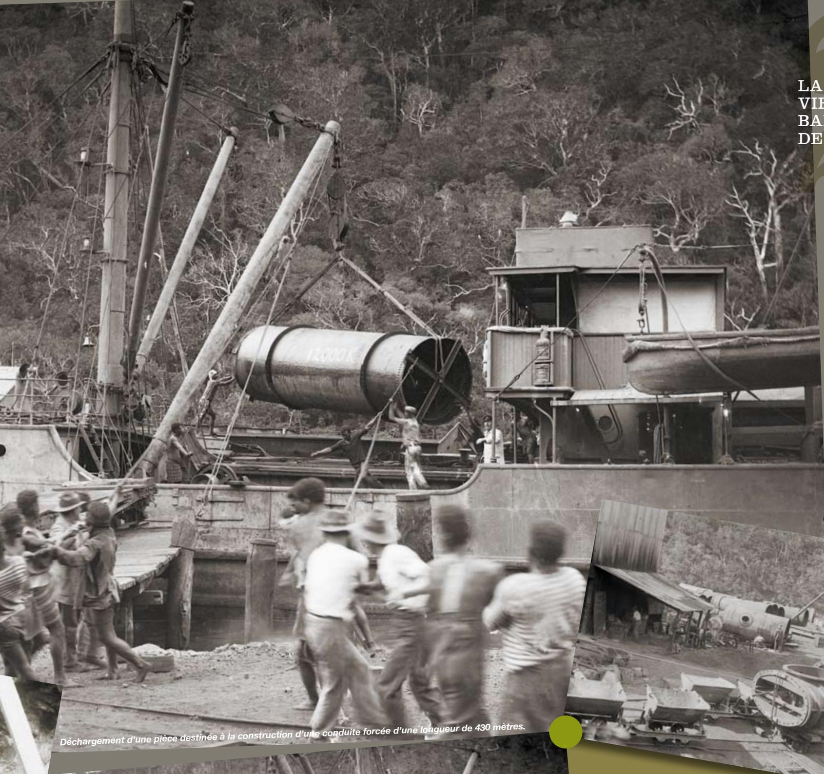
Déchargement d'une pièce destinée à la construction d'une conduite forcée d'une longueur de 430 mètres.
