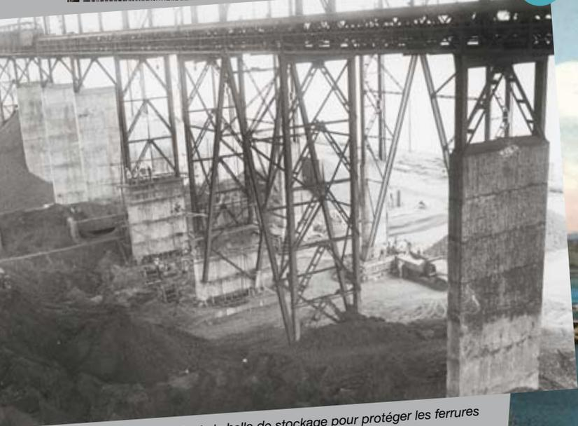
Bétonnage des pieds de la halle de stockage pour protéger les ferrures des bulldozers, 1961.
