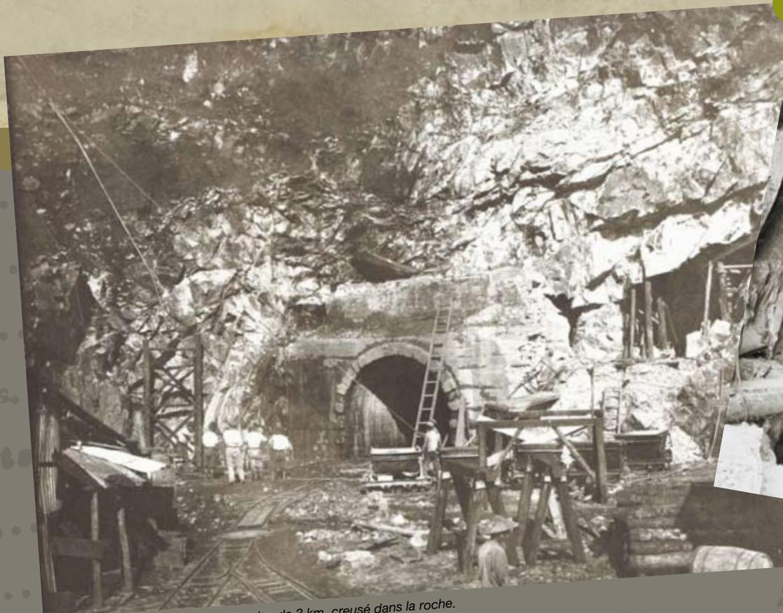
L'ouvrage comprenait un tunnel de plus de 3 km, creusé dans la roche.
